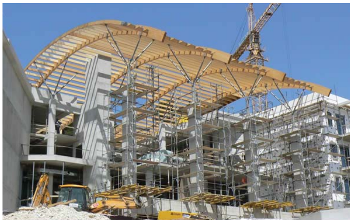
Montirani glavni i sekundarni krovni elementi
