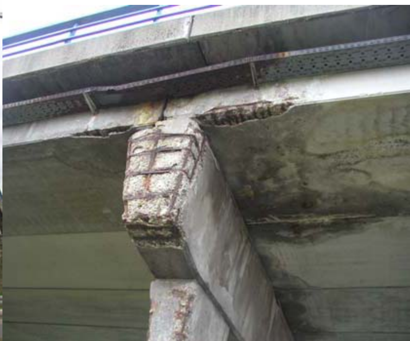
Slika 1.1: Česta oštećenja na hrvatskim mostovima
